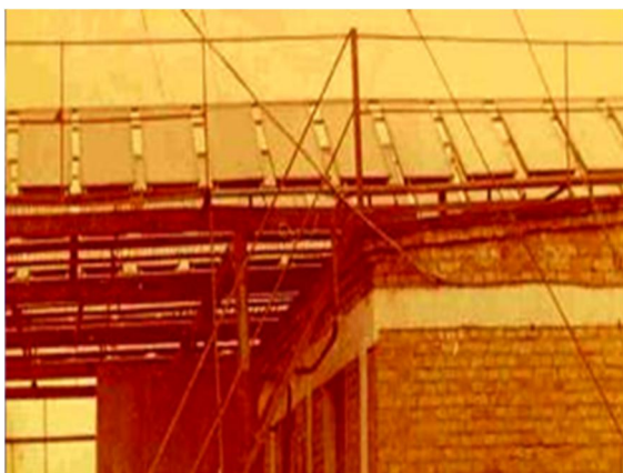
Рис.8. Комбинированная солнечная установка с котельной на МТФ.
