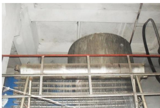
Рис. 2. Охладитель – рекуперативный многоходовой теплообменник
