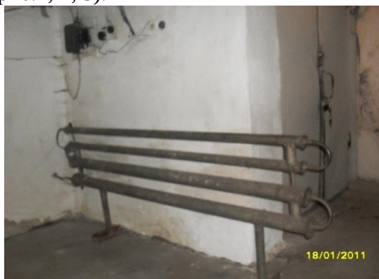
Рис.1. Охладитель «труба в трубе»
