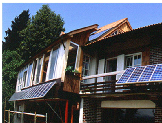
Рис. 3. Пример солнечного дома с системой горячего водоснабжения.
