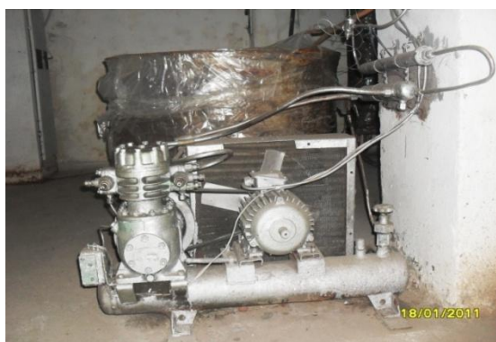
Рис.3. Охладитель змеевиковый.
