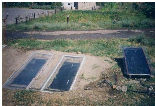
Рис. 2. Общий вид грунтового солнечного водонагревательного коллектора.
