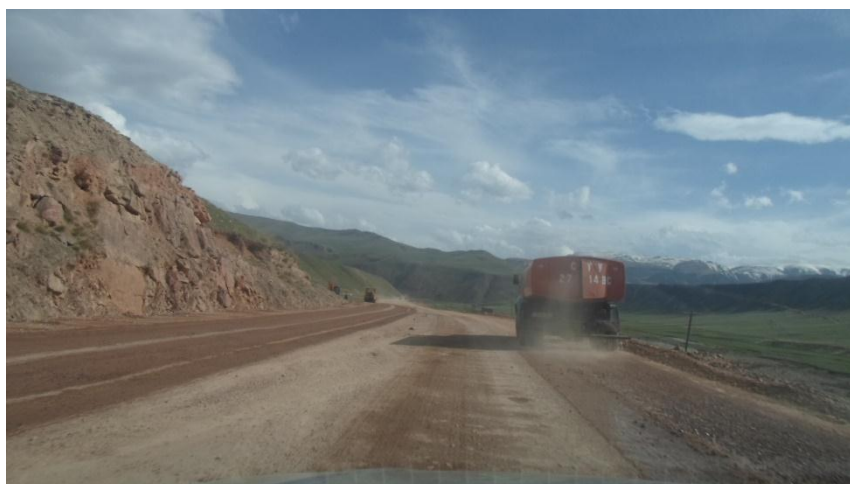
Рисунок 5. Реконструируемый участок дороги Перевал «Долон» (223-244 км)
