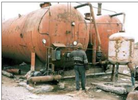
Рис. 3. Действующая БЭМС-120 Сокулукский район. Объем реактора 120 м 3
