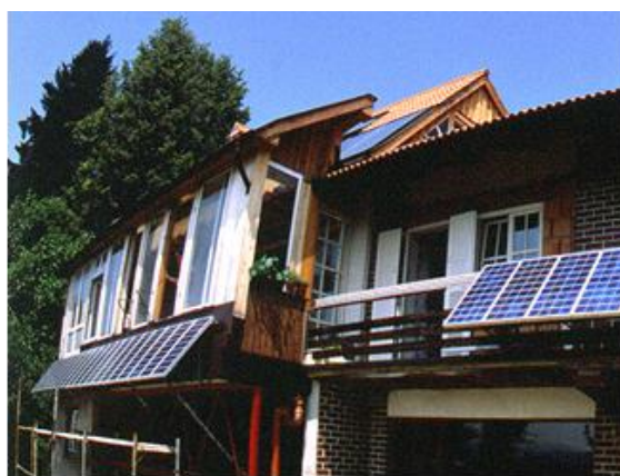
Рис. 3. Пример солнечного дома с системой горячего водоснабжения
