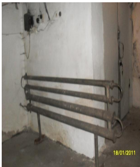
Рис.1 Охладитель «труба в трубе»
