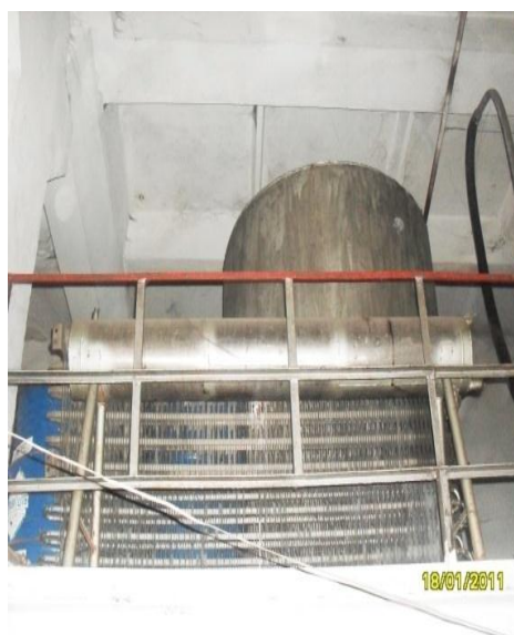
Рис. 2.Охладитель рекуперативный многоходовой теплообменник
