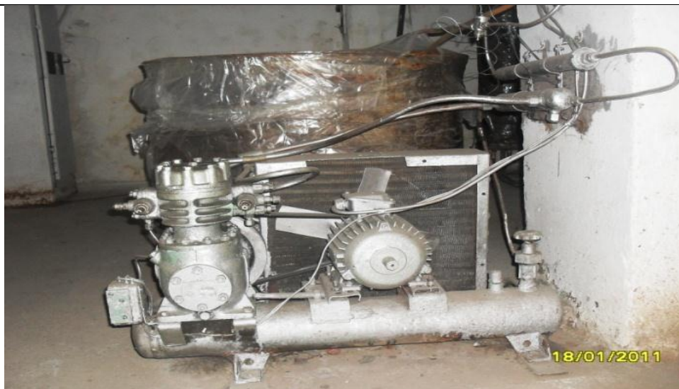
Рис.3. Охладитель змеевиковый
