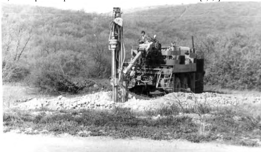
Рис.1. Бурение скважин автономным буровым агрегатом УБА-1 «Аскатеш» на объектах г.Севастополя
