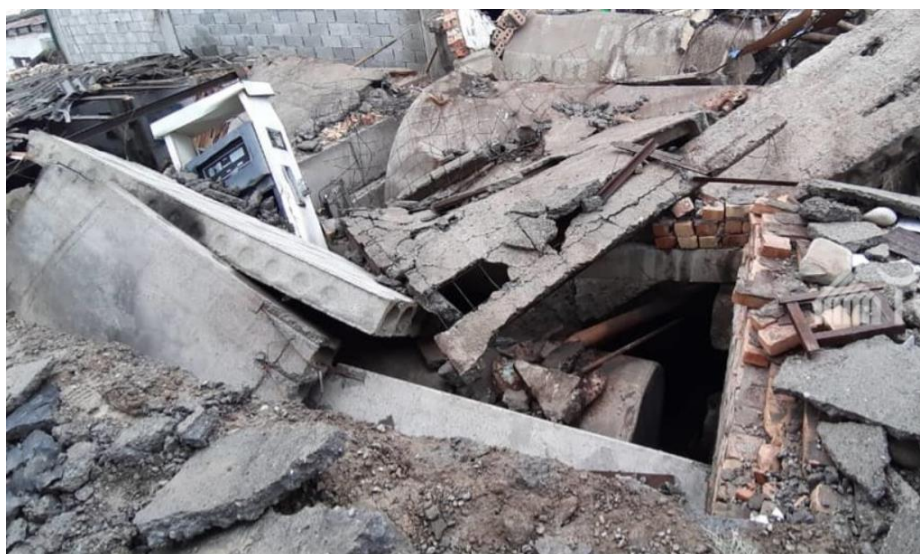
Рис.3. Состояние резервуара АЗС «Октан Сервис» после взрыва
