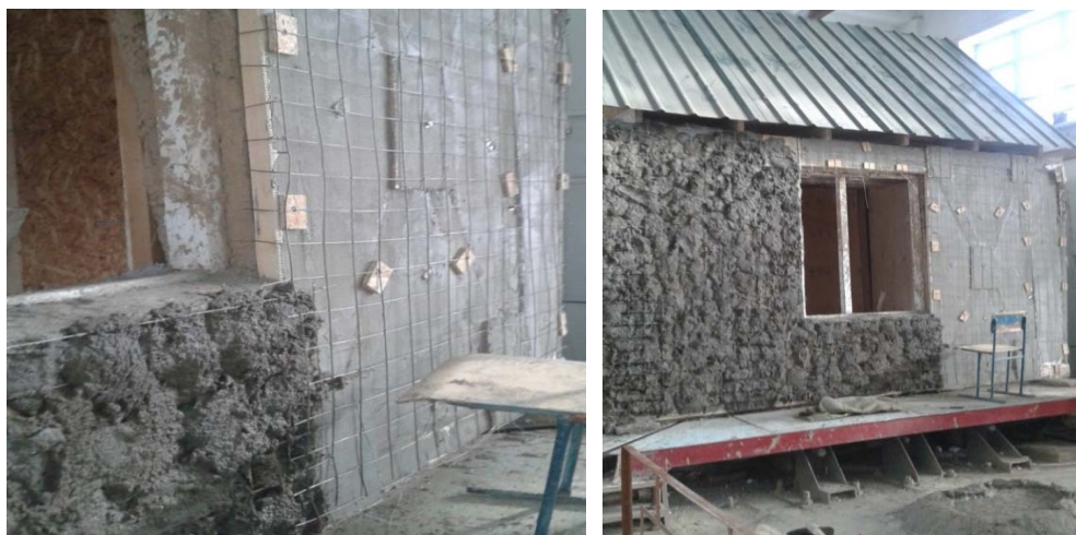
Рис.4. Установка вертикальных сеток снаружи и штукатурка цементно-песчаным раствором
