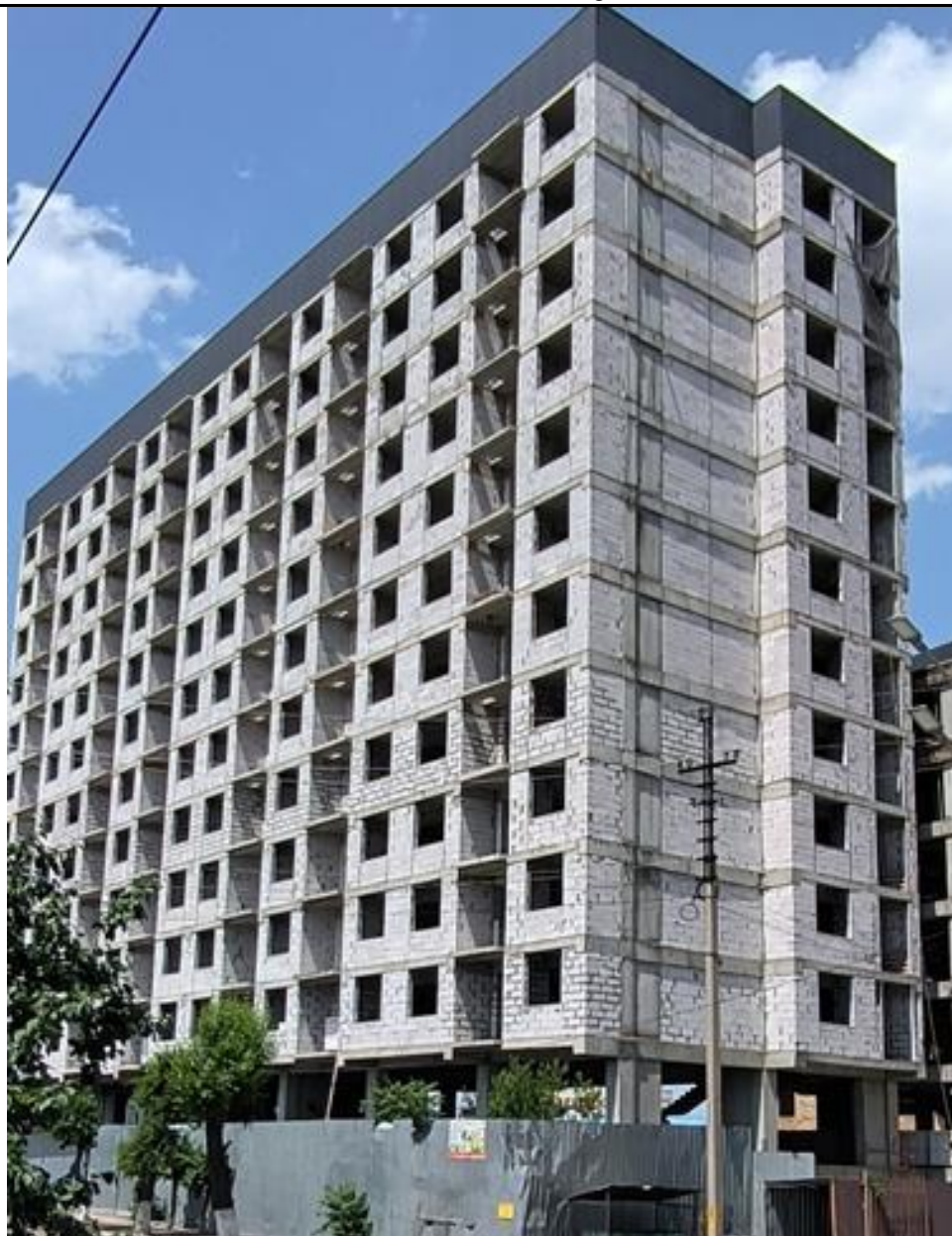
Рис. 2. Строящийся 12-этажный жилой дом
