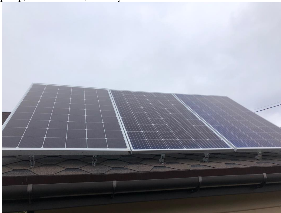
Рис.1. Установка ФСМ на станции с солнечным трекером: а - HEVEL HVL 290 Вт, б - DELTA SM 250-24 М, в - DELTA SM 250-24 P
