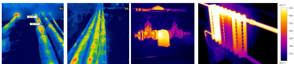
Рис. 9. Тепловизионное изображение тепловых сетей и отопительных радиаторов
