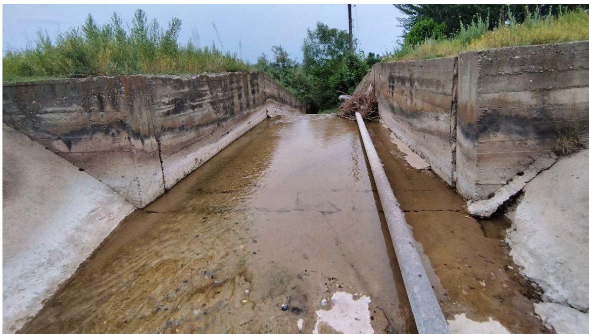
Рис.2. Входная часть сбросного сооружения ПК 312+77
