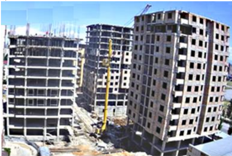
Башенный кран КБ-100.3А на рельсовом ходу на объекте "Джал Ордо" в г.Бишкек, Застройщик ОсОО "Аалам Строй"
