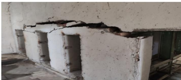
Рисунок 21 - Общий вид строительных конструкций в здании компрессорной (трещины из-за просадки оснований и полов)
