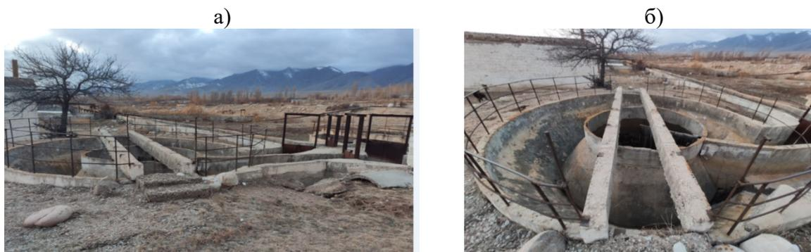
Рисунок 6 - Общий вид песколовки(горизонтальной) с круговым движением сточной воды
