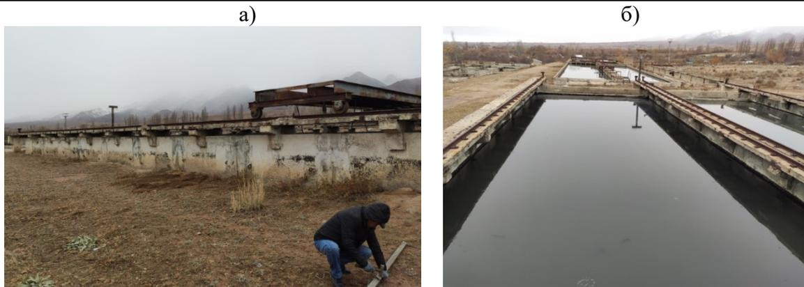
Рисунок 7 - Общий вид первичного горизонтального отстойника (ракурс 1)
