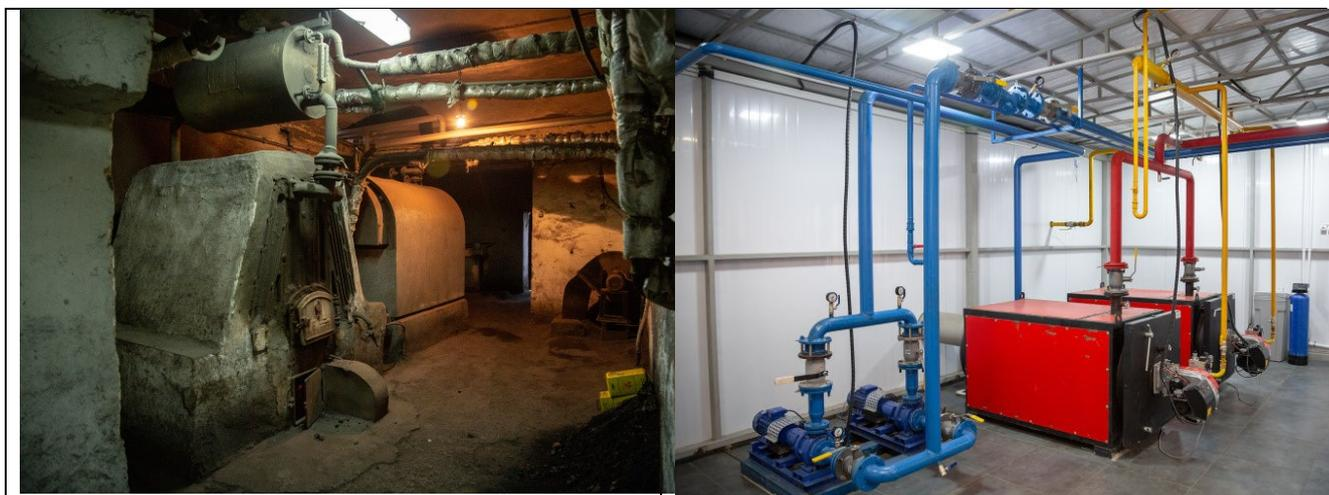
Рисунок 3 - Реконструкция и модернизация котельных с переводом на природный газ
