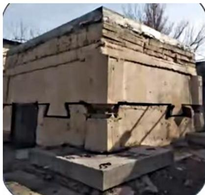
а) сейсмоплатформа из ж/б конструкции ее шаровая опора
