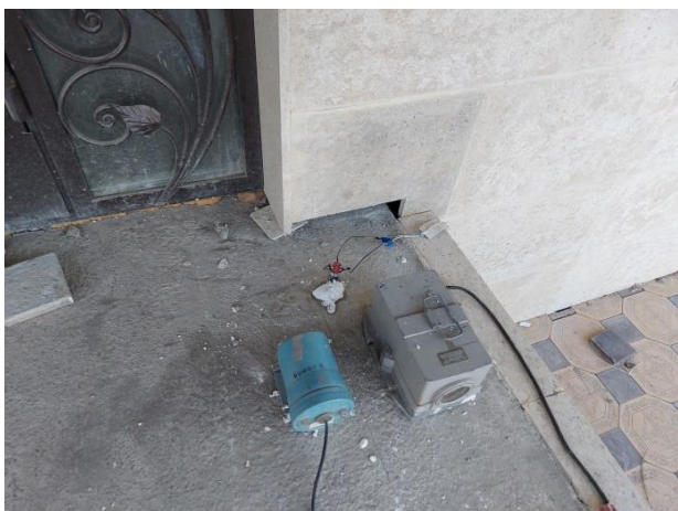
Фото 3 - Приборы на подъездной площадке здания (сеймоприемники ОСП, СМ-3, СМВ-30S)
