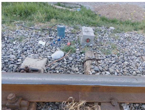
Фото 4 - Приборы на основной площадке земляного полотна железной дороги (сеймоприемники ОСП, СМ-3, СМВ-30S)
