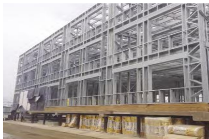
Рисунок 8 - Каркас здания из ЛСТК в Якутске
