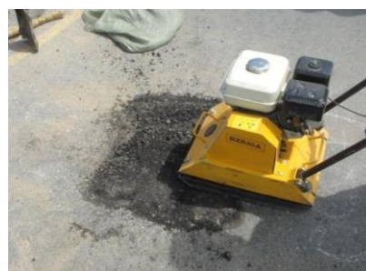
Рисунок 3 – Заделка места отбора проб
