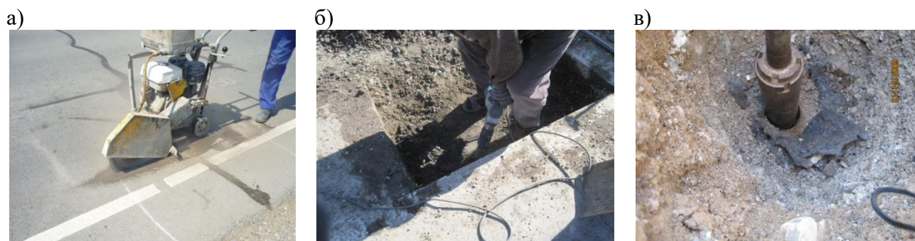
Рисунок 1 – Оборудование для вскрытия дорожных одежд:
